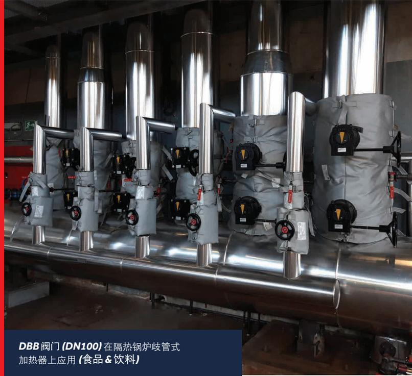
DBB 阀门 (DN100) 在隔热锅炉歧管式加热器上应用 (食品 & 饮料)
